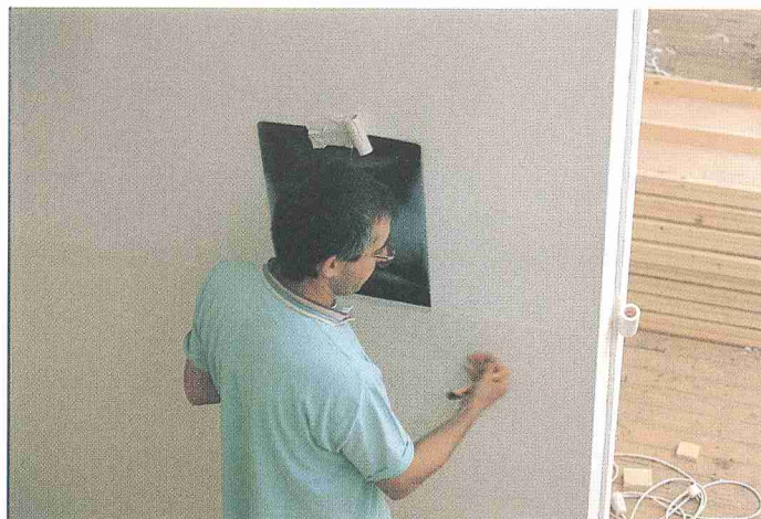
Proceso de montaje
