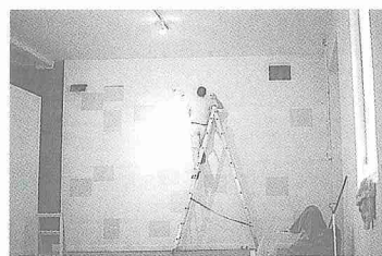
OBRA EN PROCESO. 1994
