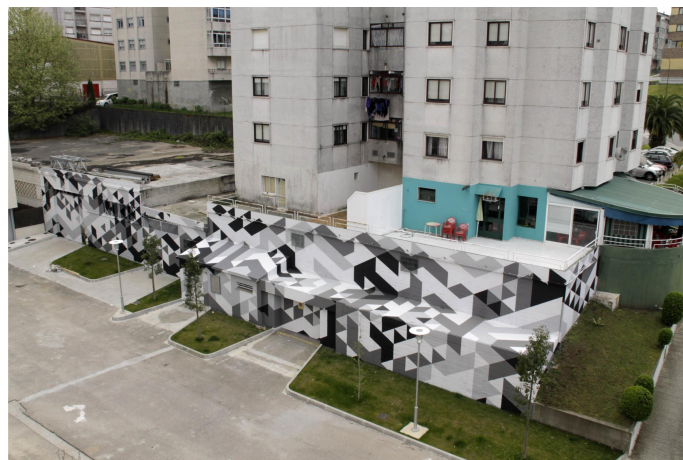
Fig. 4 - Fotografía de la propuesta, ya terminada, desde una de las casas vecinas. Fuente: R. Corbato
